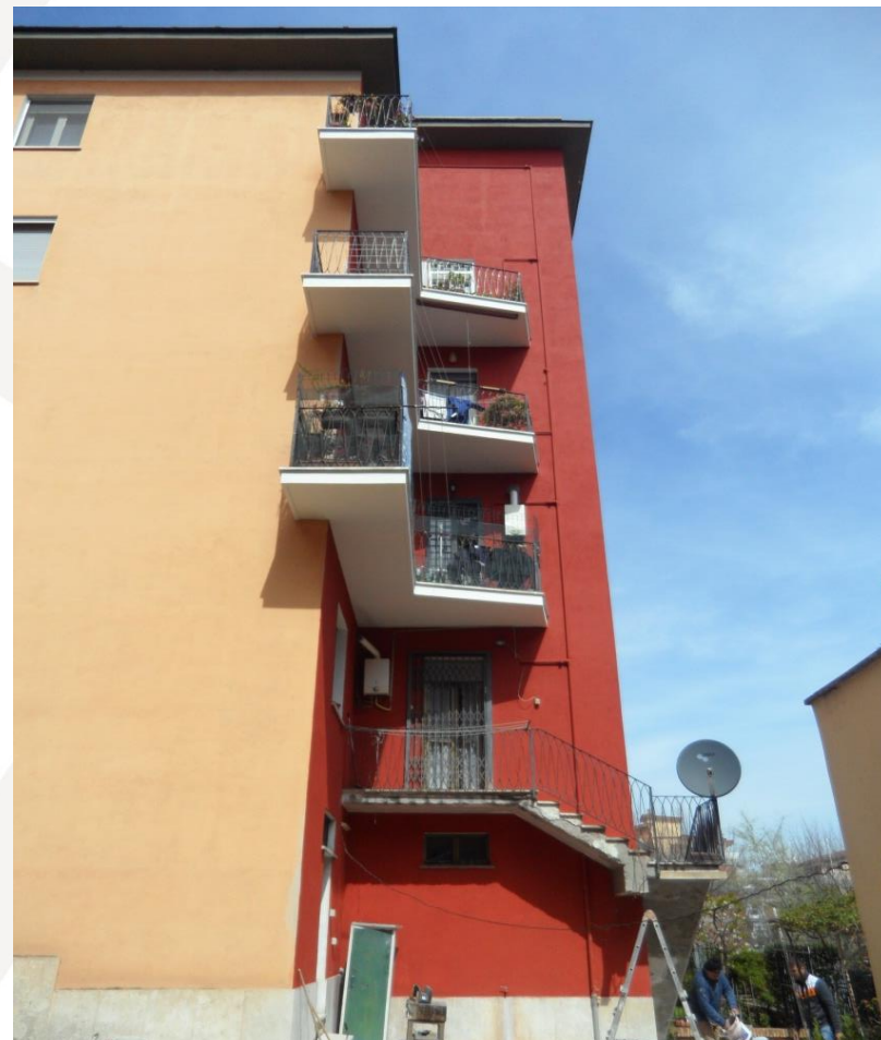
Rifacimento parziale facciata e manutenzione straordinaria Via G. Troiani, 29
