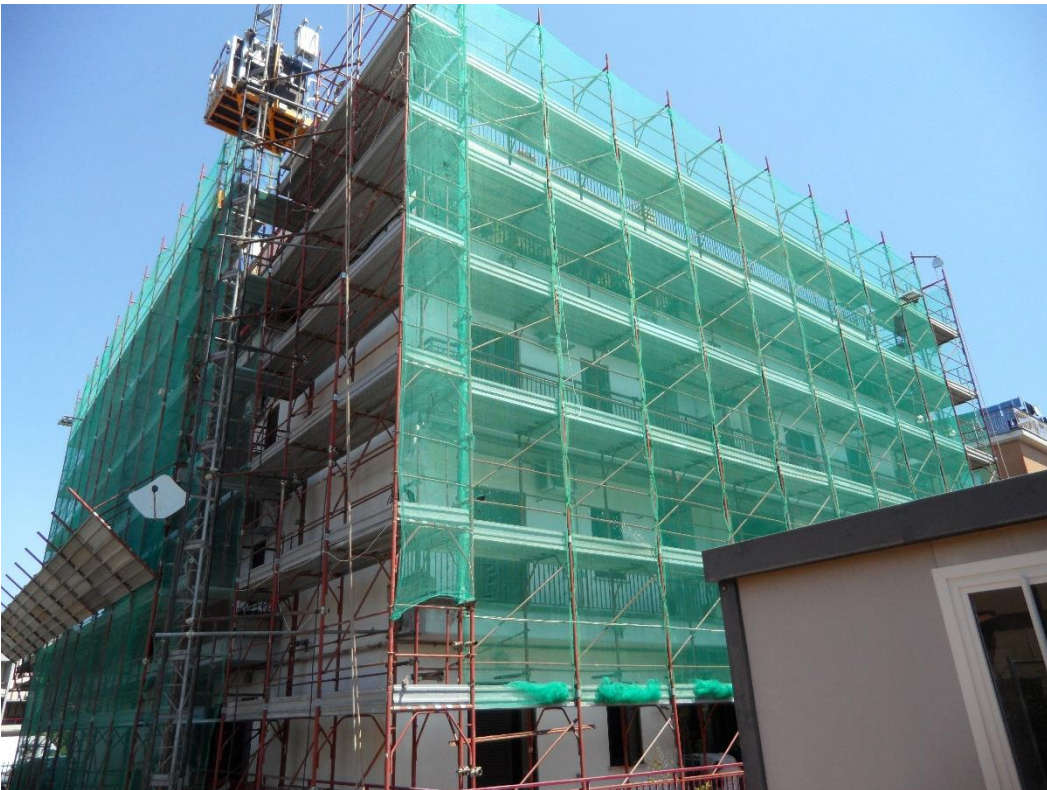
Lavori di rifacimento lavori di rifacimento lastrico solare e facciate Via di Casalotti, 251 – Roma
