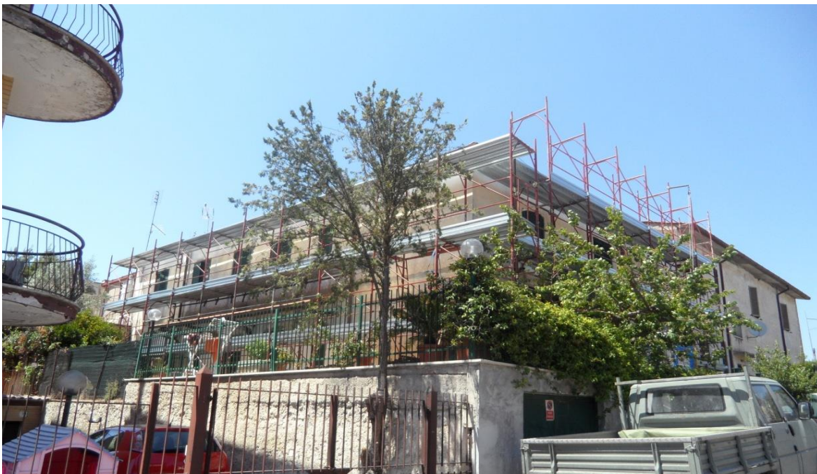
Rifacimento facciate e tetto ventilato in legno Via G. Ronconi, 101 Roma
